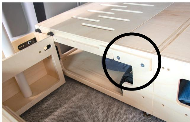
5. Installez les supports de table sur le module central, sur la moitié sélectionnée opposée au support en U. Vissez depuis l'intérieur de la boîte, en utilisant une vis et une rondelle par trou.
